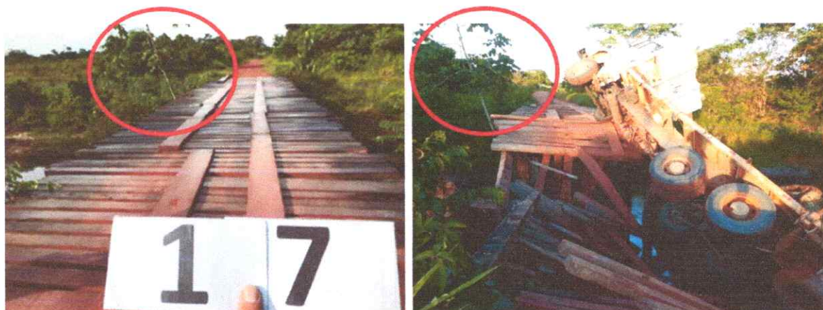
Figura 6. Ponte classificada como crítica no monitoramento realizado dia 19/11/2021, queda da ponte no dia 22/11/2021, devido ao excesso de peso do caminhão, não houveram vítimas.
